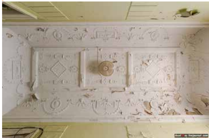
Илл. 11. Фрагмент интерьера парадной лестницы. Потолочные плафоны и падуго с сохранившейся лепниной. Фотография Вадима Разумова
