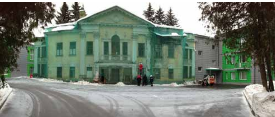
Илл. 5. Вид на северный фасад усадьбы. Состояние на 2015 г.
