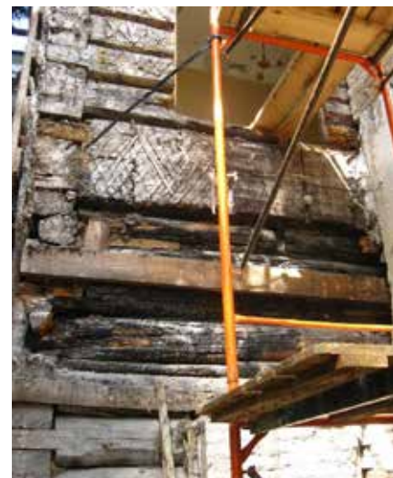
Илл. 16. Зондажное раскрытие наглядно демонстрирует следы пожара и места ранней переборки деревянных конструкций
