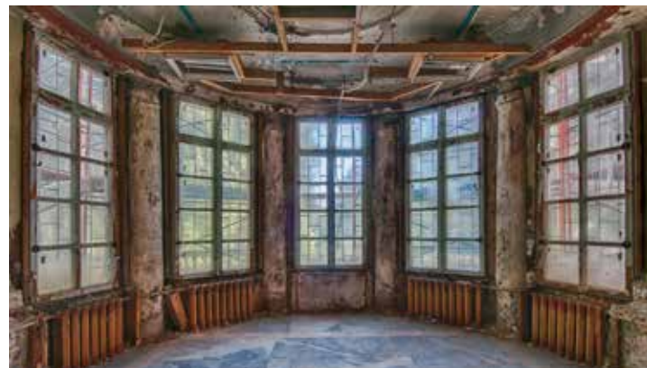
Илл. 15. Зондажное раскрытие колоннады первого этажа. Фотография Вадима Разумова
