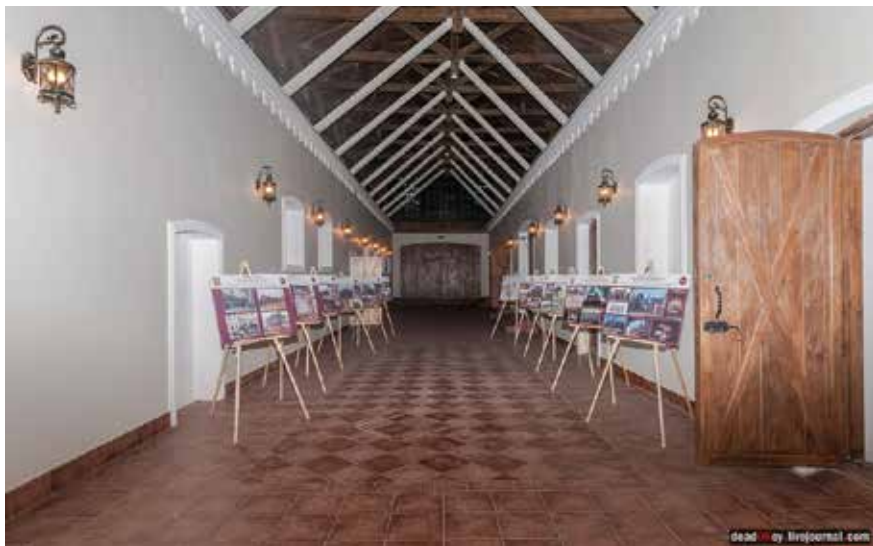
После реставрации в центральном пролёте конюшни разместится интерактивный музей. Белым цветом реставраторы выделили новые элементы несущих конструкций кровли.
