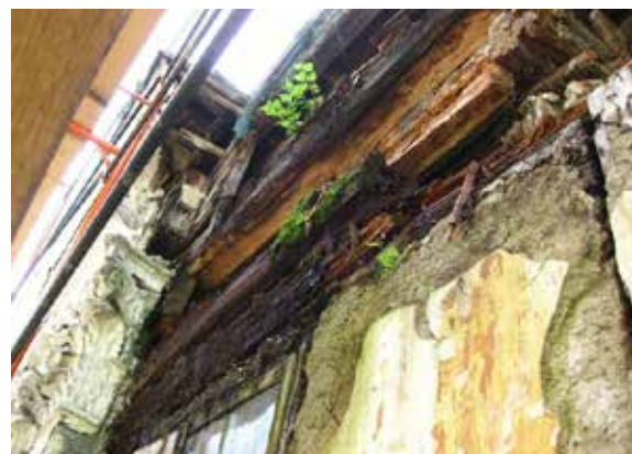
Илл. 19. Деструктивный участок внешней несущей стены
