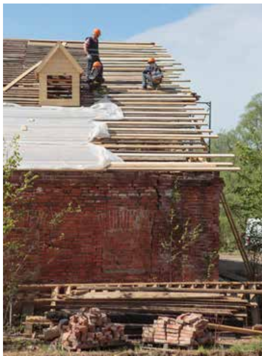
Восстановление слуховых окон на крыше конюшни соответствует исторической правде, а под кровлей будет размещен интерактивный музей
