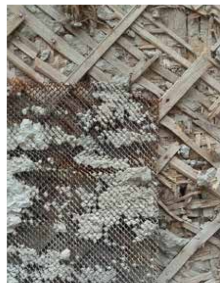
Илл. 17. Зондажное раскрытие фрагмента деревянной стены, оштукатуренной по металлической сетке, набитой по дранке
