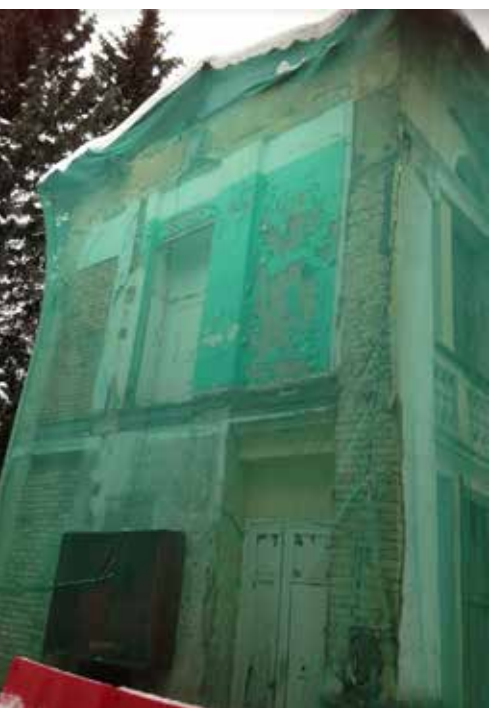
Илл. 7. Фрагмент восточного фасада. Состояние на 2015 г.
