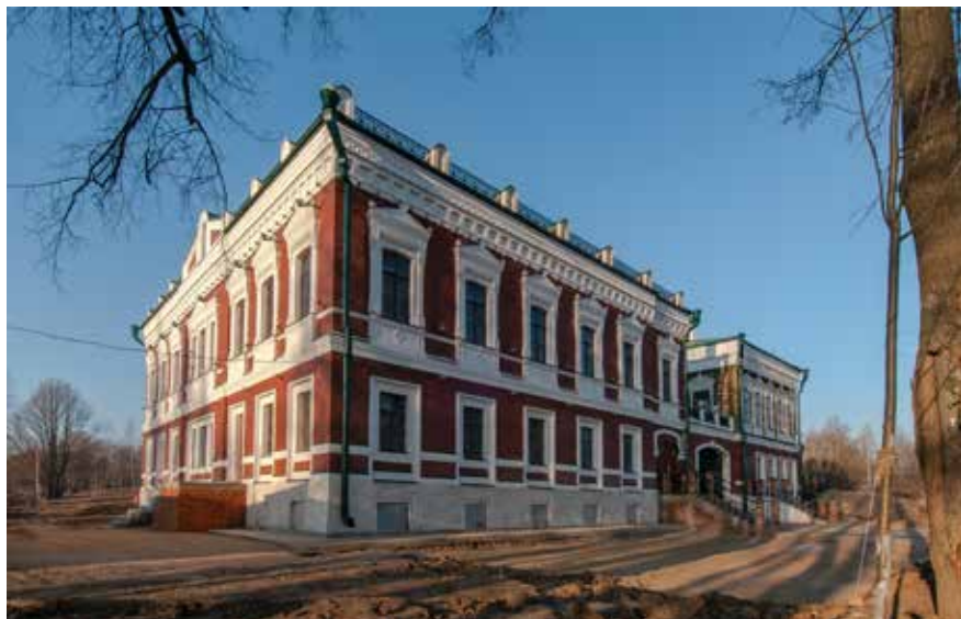
Таким усадебный дом и флигель были через год после начала работ – ноябрь 2014
