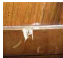
Многочисленные мелкие трещины, царапины, вмятины, сколы древесины
