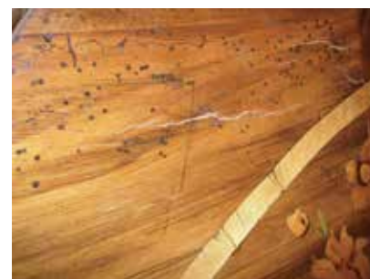
Поражение древесины жуком-древоточцем, многочисленные мелкие трещины
