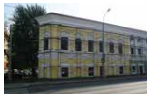
Здание в процессе реконструкции и реставрации
