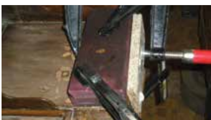
Укладка вздутий шпона
