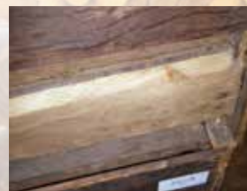
Трещины, дефекты и сколы на задней стенке
