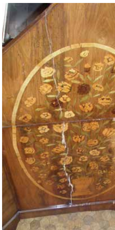
Заделка трещин на наборе маркетри
