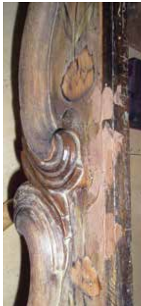
Заделка трещин и щелей мастичными шпаклевками
