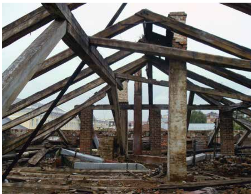
Восстановление кровли одного из объектов
