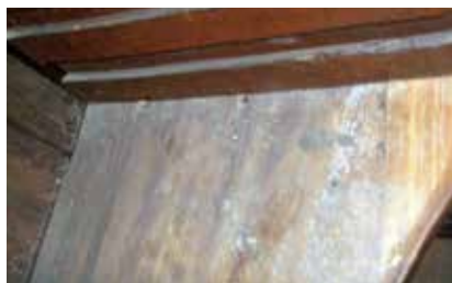
Состояние полок: множество царапин, трещин и сколов, истирание лакового покрытия, деформация конструктивных элементов
