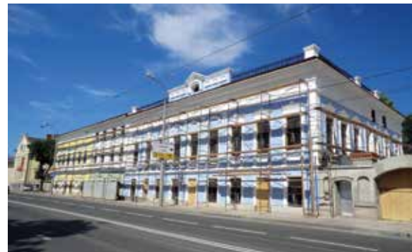
Здание в процессе реконструкции и реставрации
