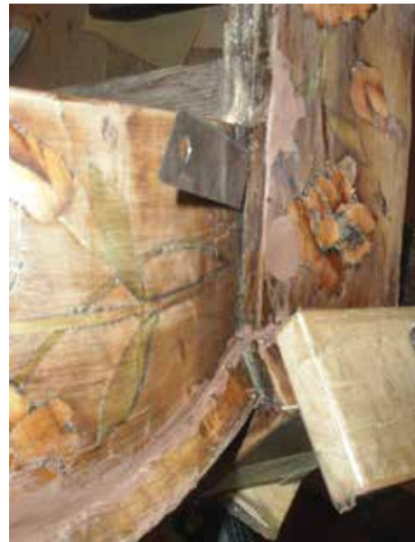
Заделка трещин и щелей мастичными шпаклевками
