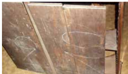
Деформация досок задней стенки
