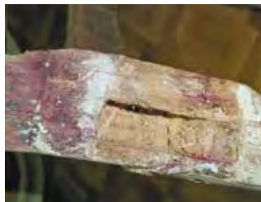
Разрушение пазов.
