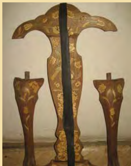
Деталь спинки с наложенным резиновым жгутом и ножки после удаления лакового покрытия.
