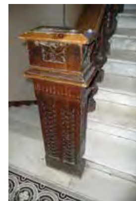
Сохранившиеся деревянные перила художественной работы и мраморная лестница
