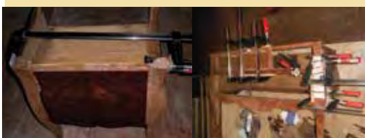
Большой объем работ был выполнен по устранению деформаций конструкции.
