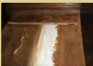
Заделка трещин мастичной шпаклевкой.
