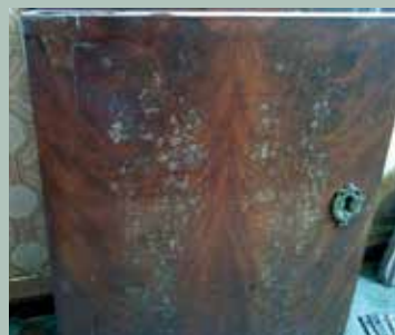
Разрушение полировки, поражение грибком.
