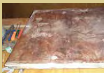
Шпаклевка дефектов дверцы (в процессе).
