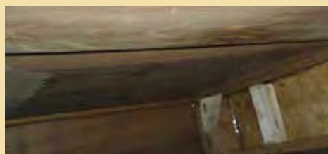
Финишная обработка заделанных трещин и восстановление фанеровки.
