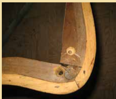
Закрепление стыков нагелями.
