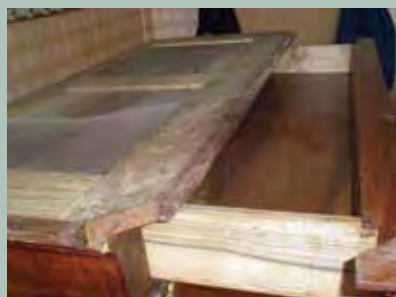
Утрата угла в верхней части (фрагмент сохранился).
