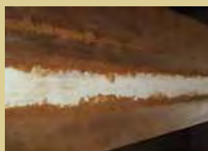
Заделка трещин мастичной шпаклевкой.
