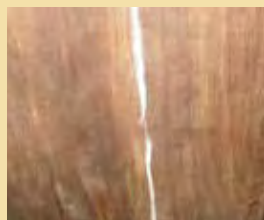
Финишная обработка заделанных трещин и восстановление фанеровки.
