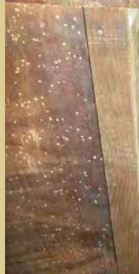
Заделка после биообработки выходов жука-древоточца.
