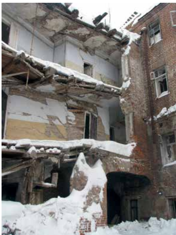
Рис. 7. До начала реставрационных работ. 29 февраля 2012 года
