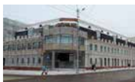
Торгово-развлекательный комплекс по улице Московская в процессе строительства
