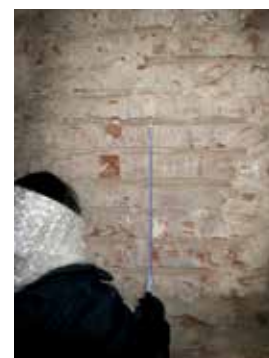
Рис. 9. Большемерный кирпич в кладке стен
