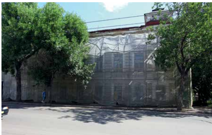
Рис. 5. Начало реконструкции. 2012 г.
