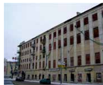
Фасад дома №81, 83 по ул.Тукаевская до реконструкции
